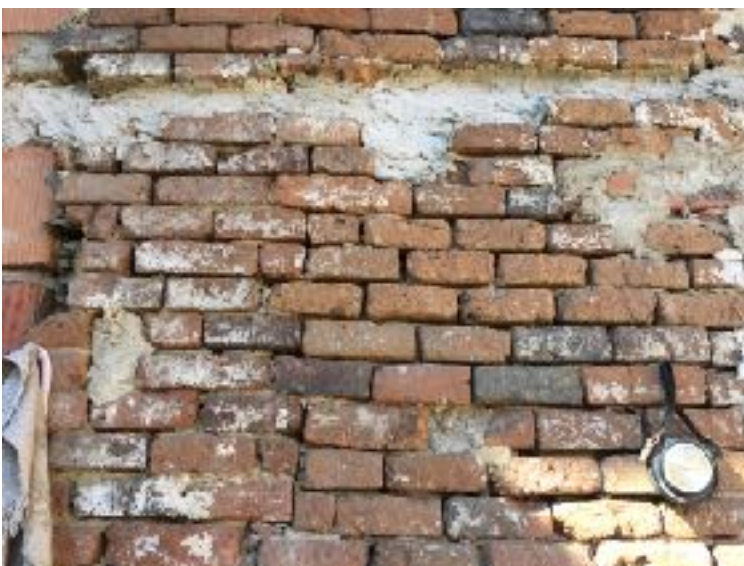
Abb. 12: Mauer mit Lehmfugen
